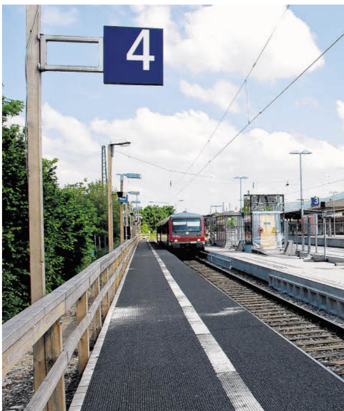
Der Bensheimer Bahnhof ist bereits umgebaut und für eine neue Strecke gerüstet.
